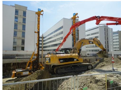
Abb. 28 Ausleger der Betonpumpe
