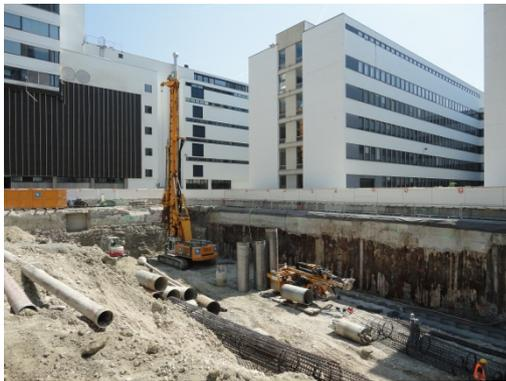
Abb. 29 Baugrube mit Bohrrohren und Bewehrungskörben
