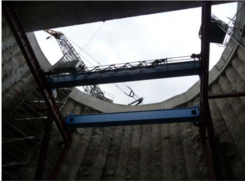
Abb. 3 Blick aus der Baugrube der Startgrube: Überschnitte Bohrfahrlingwand mit Stahlbetonkopfplatte
