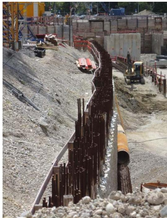
Abb. 9 Überschnittene Bohrpfehlwand
