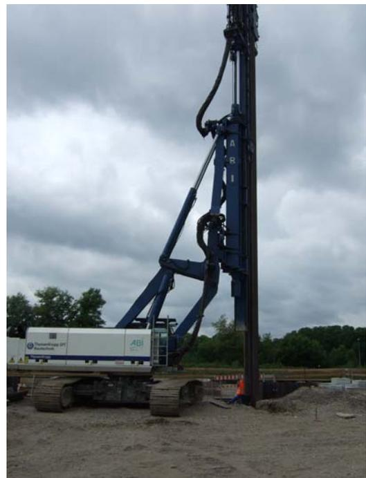
Abb. 4 Spundwand-Rammgerät
