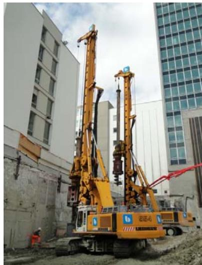
Abb. 23 Bohrgeräte bei der Herstellung der Bohrpfahlwand
