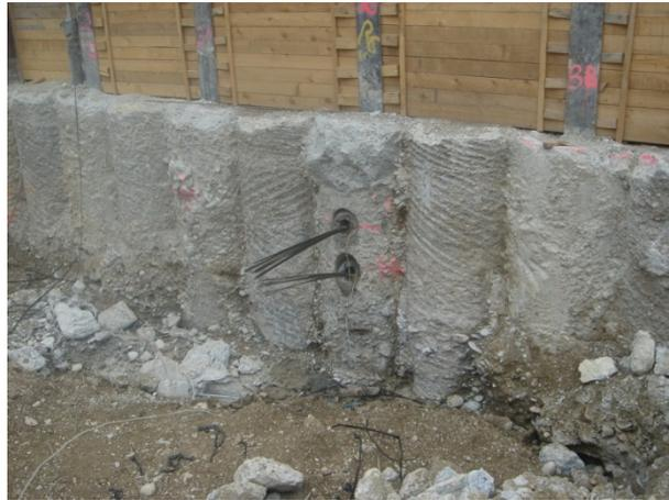
Abb. 25 Fertiggestellte Bohrfahlwand mit Anker
