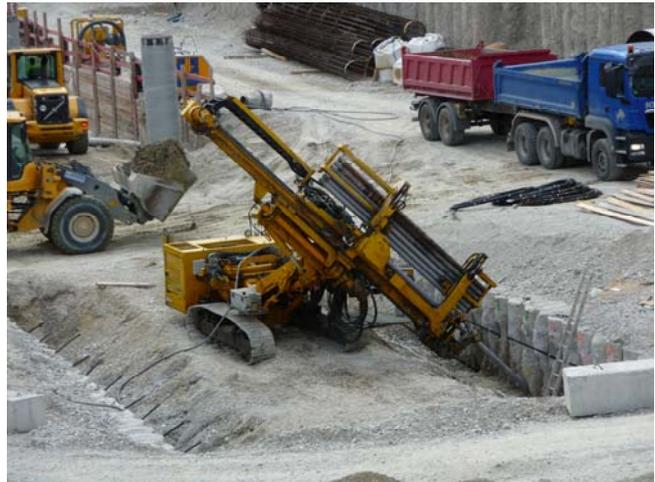
Abb. 10 Ankerbohrgerät
