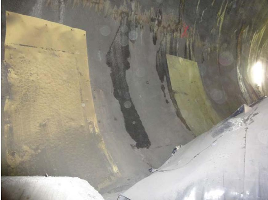
Abb. 6 Zu Probezwecken angebrachte Abdichtung
